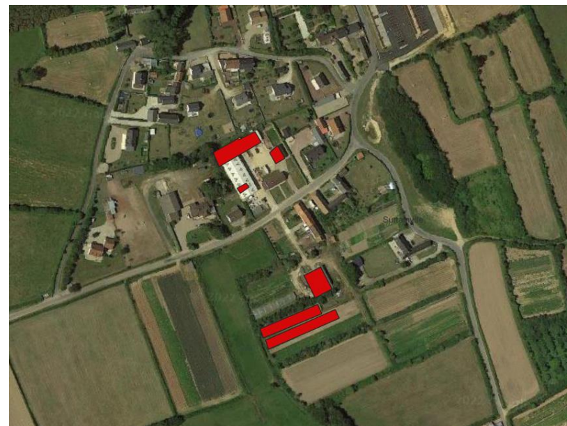
Figure 21 : Exemple de sites agricoles, soumis à pression urbaine, sur la commune de Surtainville
