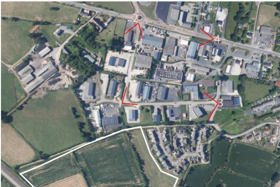
FIGURE 14 : LOCALISATION DES CONES DE VUE AU SEIN DE LA ZONE D'ACTIVITE – SOURCE : GEOPORTAIL
