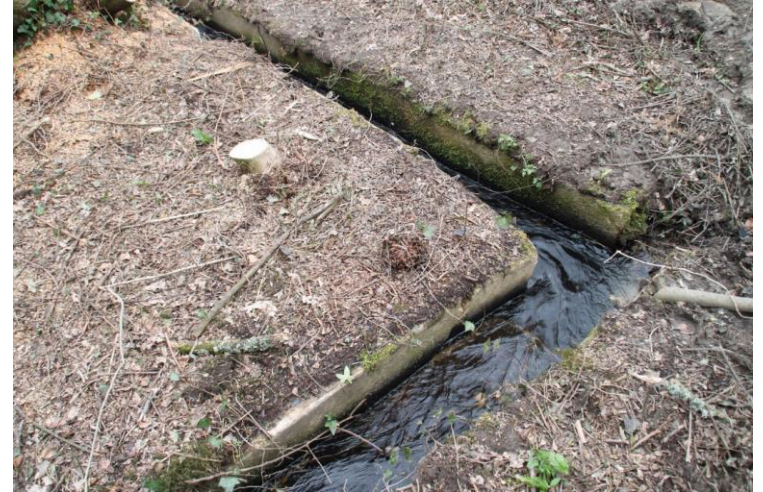
Détail trop-plein © Drac Normandie – Stéphane Lamache
